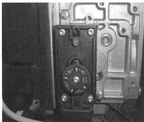
Малюнок 8.1.2 – Перемикачі низького тиску газу на вході
